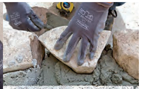
MAMPOSTERÍA DE PIEDRAS
